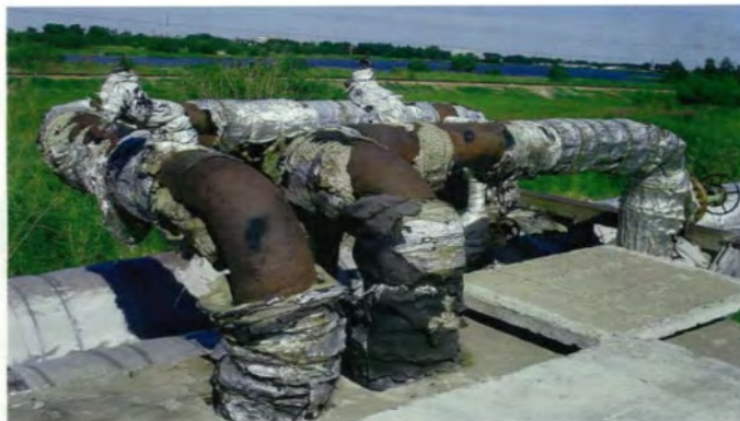
図 11 日本の工場で見られる熱輸送配管における保温断熱材の劣化
